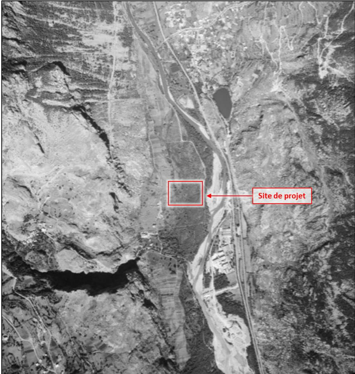
Photographie 4 : Vue aérienne aux abords du site de projet en 1980 (IGN-Géoportail)
